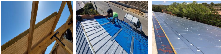
Ilustração 5 - Colocação de isolamento térmico
