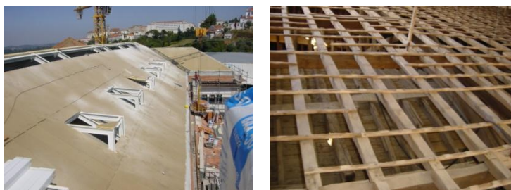
Ilustração 3 - Estrutura contínua ou descontinua
