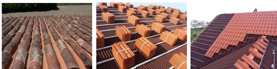
Ilustração 4 - Telhas de Canudo, Marselha, Lusa ou outras
