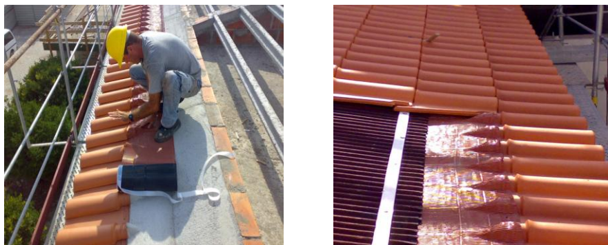
Ilustração 9 - Remate de beirado
