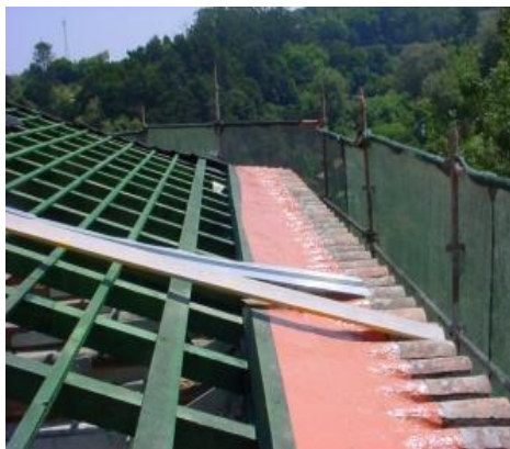
Figura 12 - Posição correta do ripado para telha canudo
