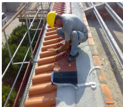
Ilustração 9 - Remate de beirado
