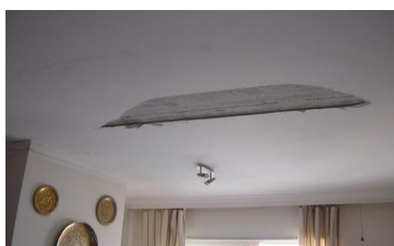
Ilustração 1 - infiltrações junto a beirado e queda de teto
