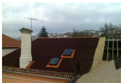
Figura 14 - Estrutura contínua de apoio
