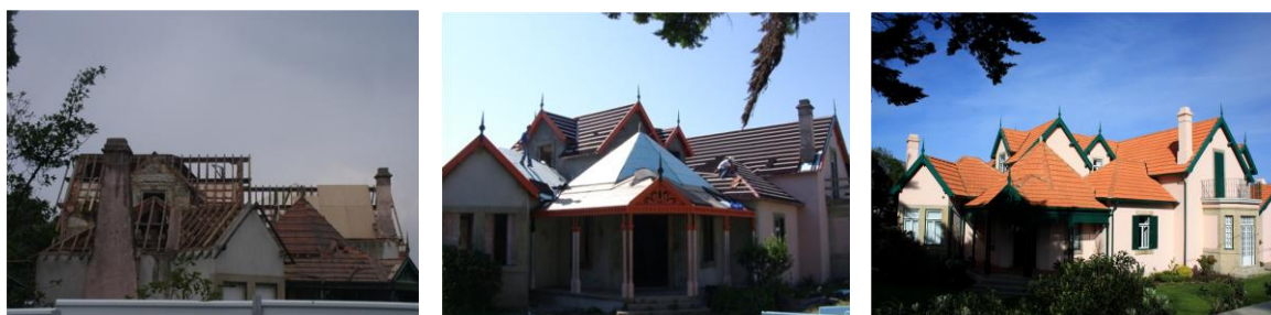
Ilustração 12 - Diferentes fases de execução de uma cobertura
