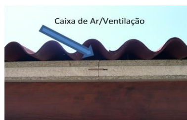
Figura 24 - Caixa de ar e ventilação
