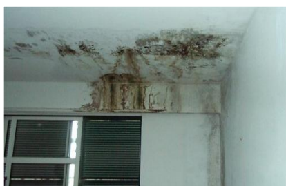
Ilustração 1 - infiltrações junto a beirado e queda de teto
