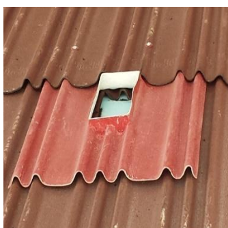
Figura 18 - Ventilador subtelha
