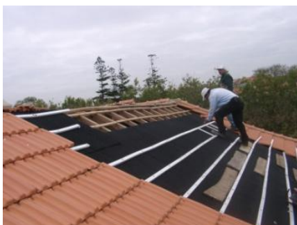
Figura 13 - Deslocação sobre as placas de subtelha
