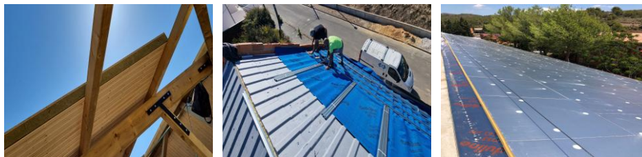
Ilustração 5 - Colocação de isolamento térmico
